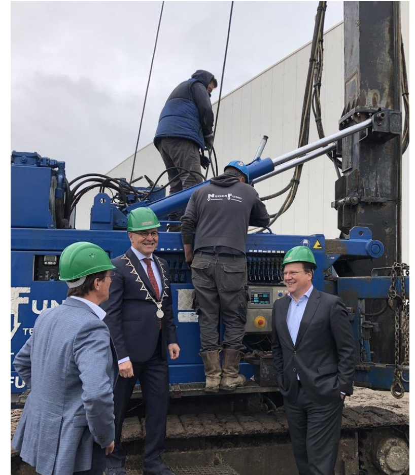
Eerste paal nieuw vers-distributiecentrum Veghel
